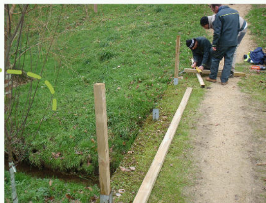
Mise en sécurité du pont de l'étang (chemin de randonnée)
