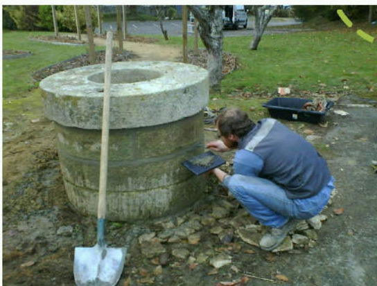
Rénovation du pont de la roseraie
