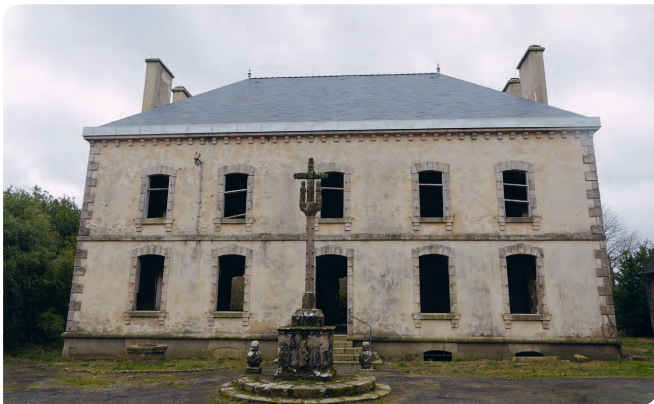
# Travaux de la future médiathèque
