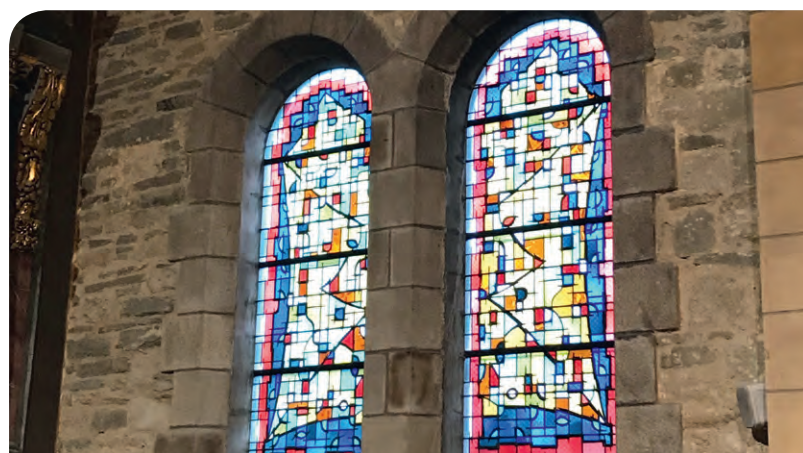
# Travaux de rénovation de l'église
