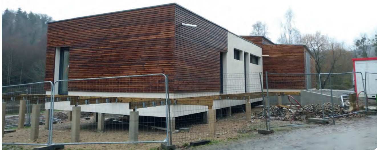
# Construction de la base nautique
