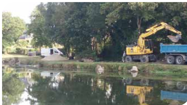
► Chantier du réseau de l'étang en septembre 2016
