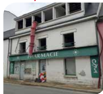
➤ L'ancienne pharmacie en déconstruction
