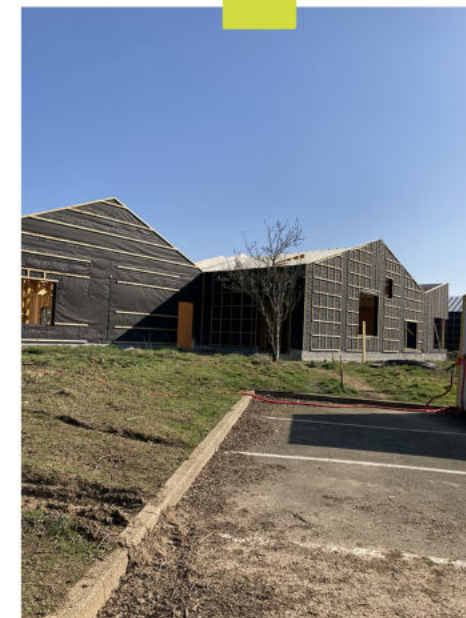
Visite de chantier - Janvier 2021
