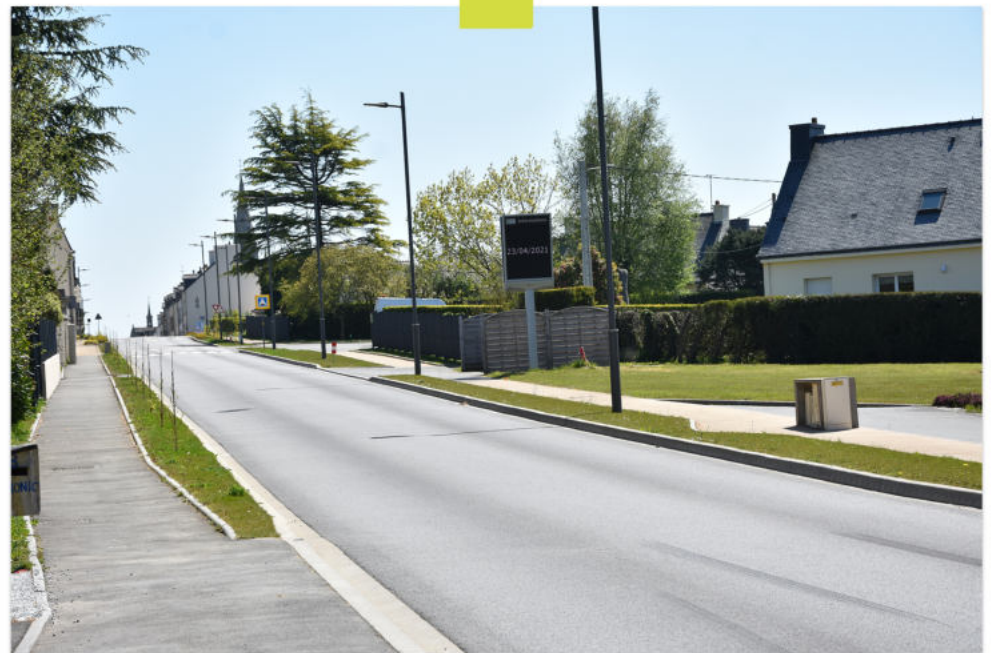
Réduction de la vitesse par l'installation de 2 plateaux et aménagement de l'entrée de bourg
